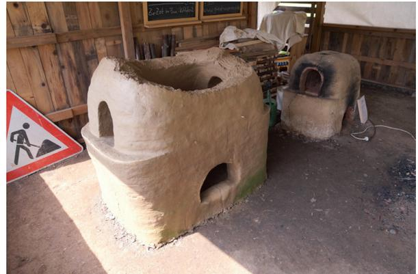
Abb. 1: Links Kühllofen KO-Borg 2 im Bau; rechts der alte Kühllofen (KO-Borg 1) (Foto F. Wiesenberg).
