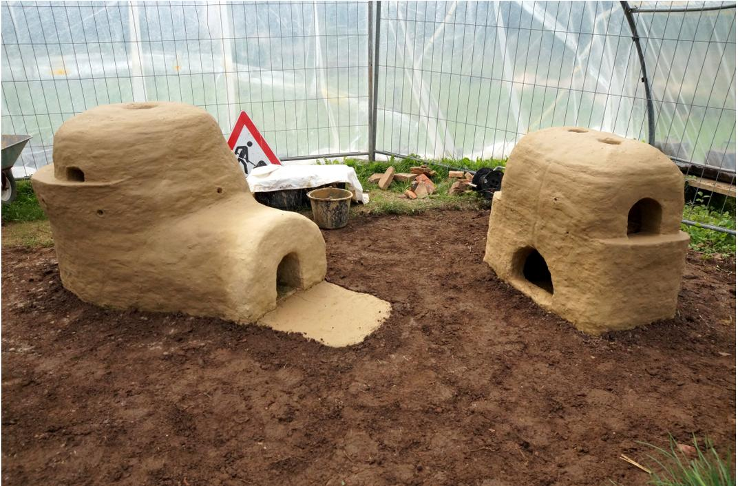
Abb. 2: „Römischer“ Glas-Schmelzofen „GO-Borg 1“ und Kühlöfen „KO-Borg 1“ kurz vor ihrer Fertigstellung (20.09.2013). – Roman-style glass furnace „GO-Borg 1“ and lehr (cooling oven) „KO-Borg 1“ almost finished (20.09.2013).
